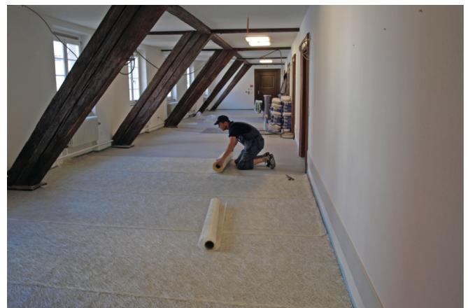
Flächiges Auslegen von UZIN RR 201 auf den zu sanierenden Untergrund.
