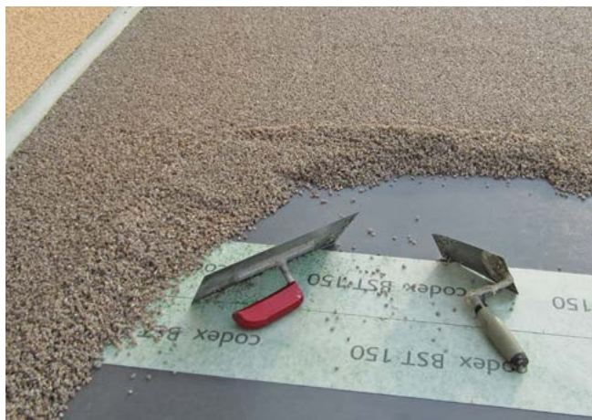
codex BalkuDrain® verlegt im System mit UZIN RR 185 und codex BST 150.
