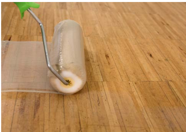
codex X-Change-Fixierung auf vorbereiteten Untergrund aufbringen.
