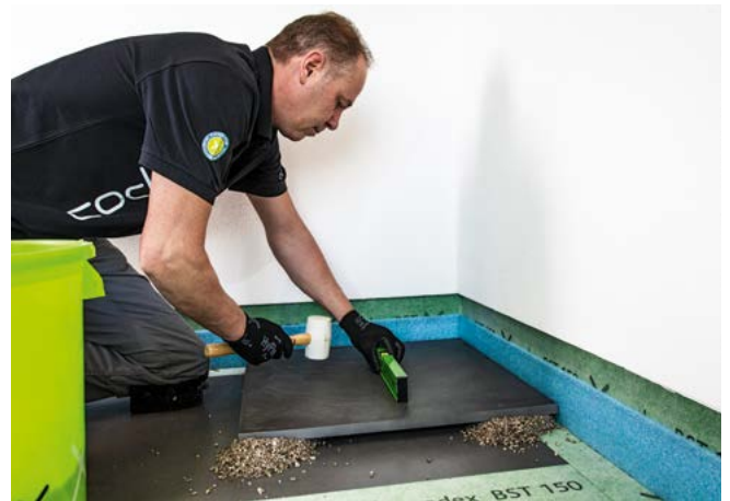
Je nach Plattendicke/-größe Belag auf 4 – 6 Batzen verlegen.
