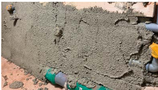
Schliessen von Leitungskanälen und Verfüllen der Installationsebenen mit FM 388 Light bis zu 15 cm Dicke in einem Arbeitsgang.
