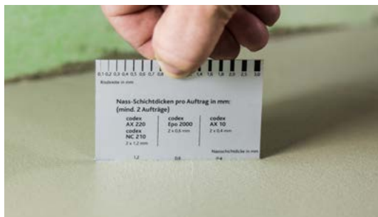
2. Kontaktschicht aufziehen und anschliessend erste Schicht mit 4 mm Zahnung aufkämmen und glatt umlegen. Nach Trocknung zweite Schicht auftragen.
