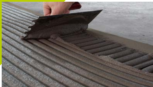
Mit der Glättkelle eine dünne, geschlossene Kontaktschicht auf den Untergrund aufkratzen, frischen Mörtel nachlegen und mit Zahntraufel gleichmässig aufkämmen.
