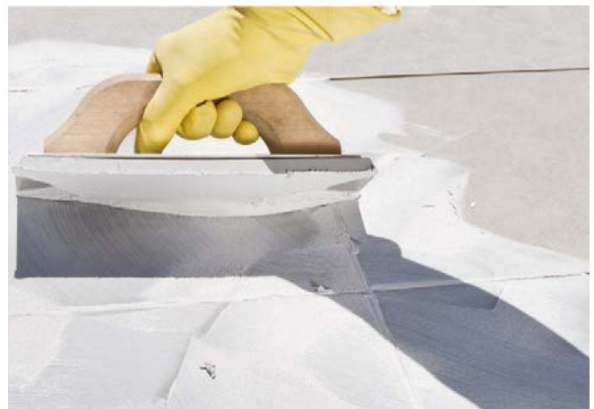
Verfugung des Fliesenbelags mit codex X-Fusion
