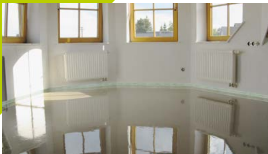
Selbstverlaufende Bodenspachtelmasse mit breitem Schichtdickenbereich und optimalen Flieseigenschaften, ideal auch für den schnellen Baufortschritt besonders in der Sanierung.
