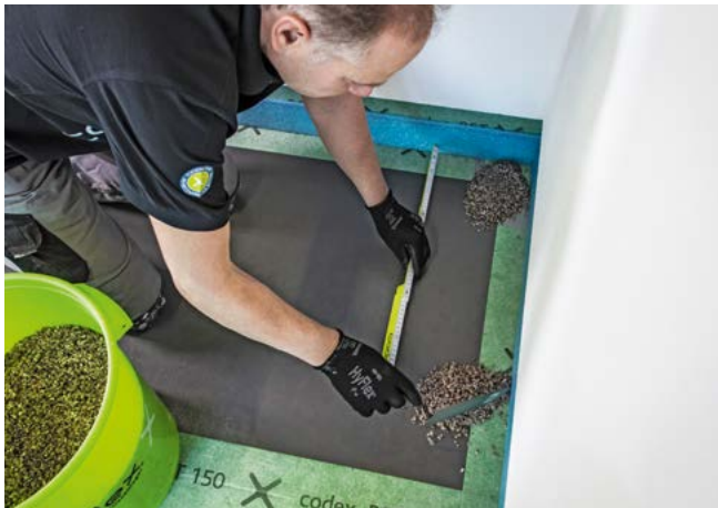
Zur besseren Anhaftung auf der Belagsrückseite mit codex ER 100 grundieren. Abstand der Mörtelbatzen entsprechend dem Fliesenformat wählen.
