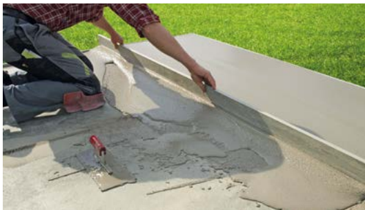
Gefälle bis max. 4% mit Richtlatte herstellen.
