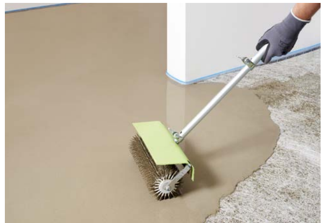
Renoviervlies UZIN RR 201 mit Fliesenspachtelmasse codex FM 50 Turbo.
