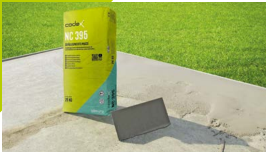
Aufbringen der geschmeidigen Gefällespachtelmasse codex NC 395.
