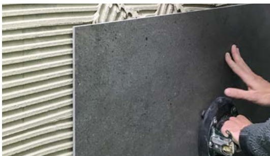
Einfache Verlegung von grossformatigen Fliesen an der Wand dank extremer Standfestigkeit.
