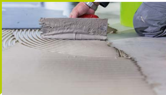
codex Power RX 4 Ultra ist hoch standfest und stabilisiert schwere Grossformatfliesen zuverlässig ohne einzusinken.
