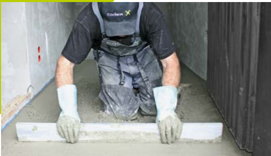
Abziehen des Estriches auf den Lehren.
