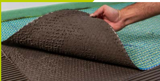
2. codex UX 430 in den Mörtel einlegen und gut anreiben.
