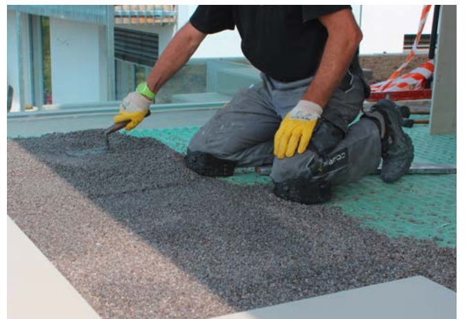
Verlegung im Epoxi-Mörtelbett aus codex ER 100 und DS 3/5.
